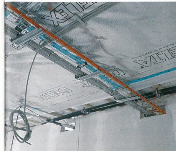
Quelle: Regnauer Fertigbau GmbH & Co. KG
